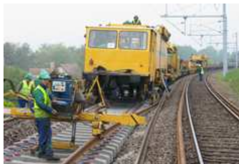
Longs Rails soudés sur traverses béton
